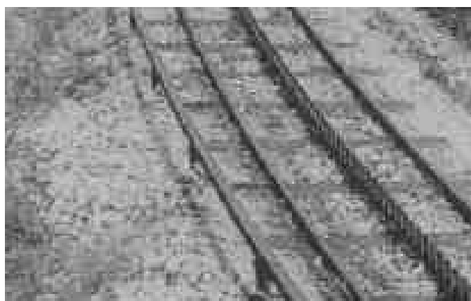
Fig. 10 - Détail de la voie en amont du tunnel ; à gauche le troisième rail alimenté en 600 volts et au centre la double crémaillère Abt entre les rails de roulement espacés d'un mètre (1914).
