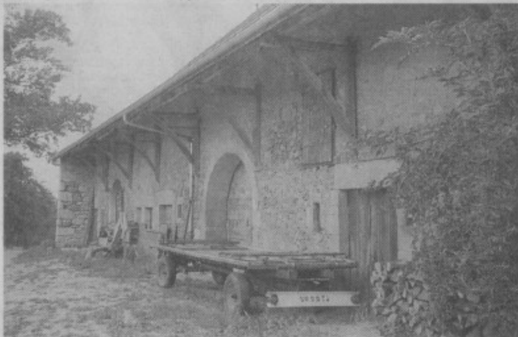
La grange de Mikerne pourrait, après restauration, devenir la maison du patrimoine où se retrouveraient Français et Suisses.
