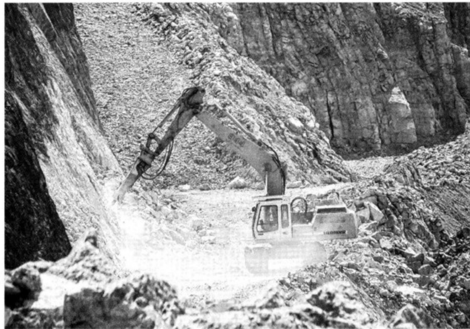
Plus de deux siècles après, la masse et la barre à mines ont été remplacées par des engins plus efficaces.
