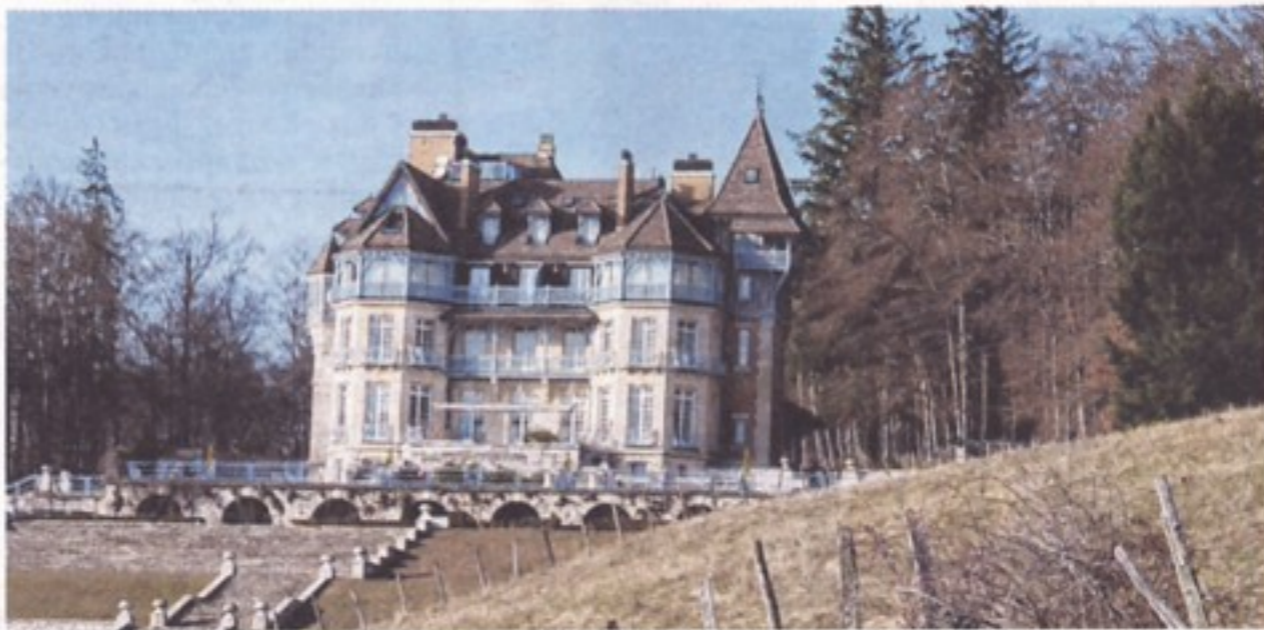
Le château des Avenièrès sur les hauteurs de Cruseilles.
