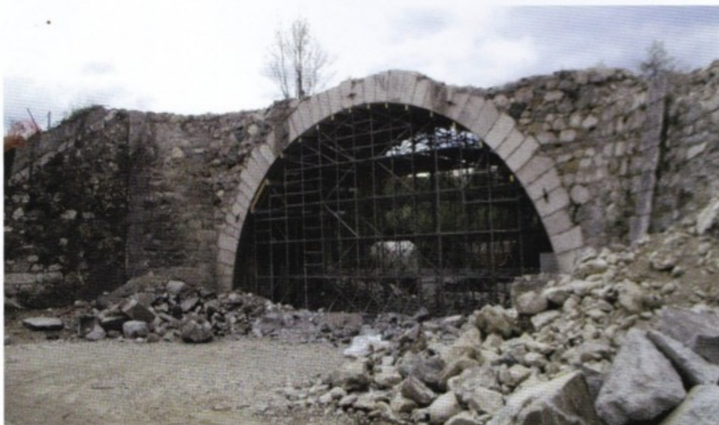
Le pont en cours de démolition.
