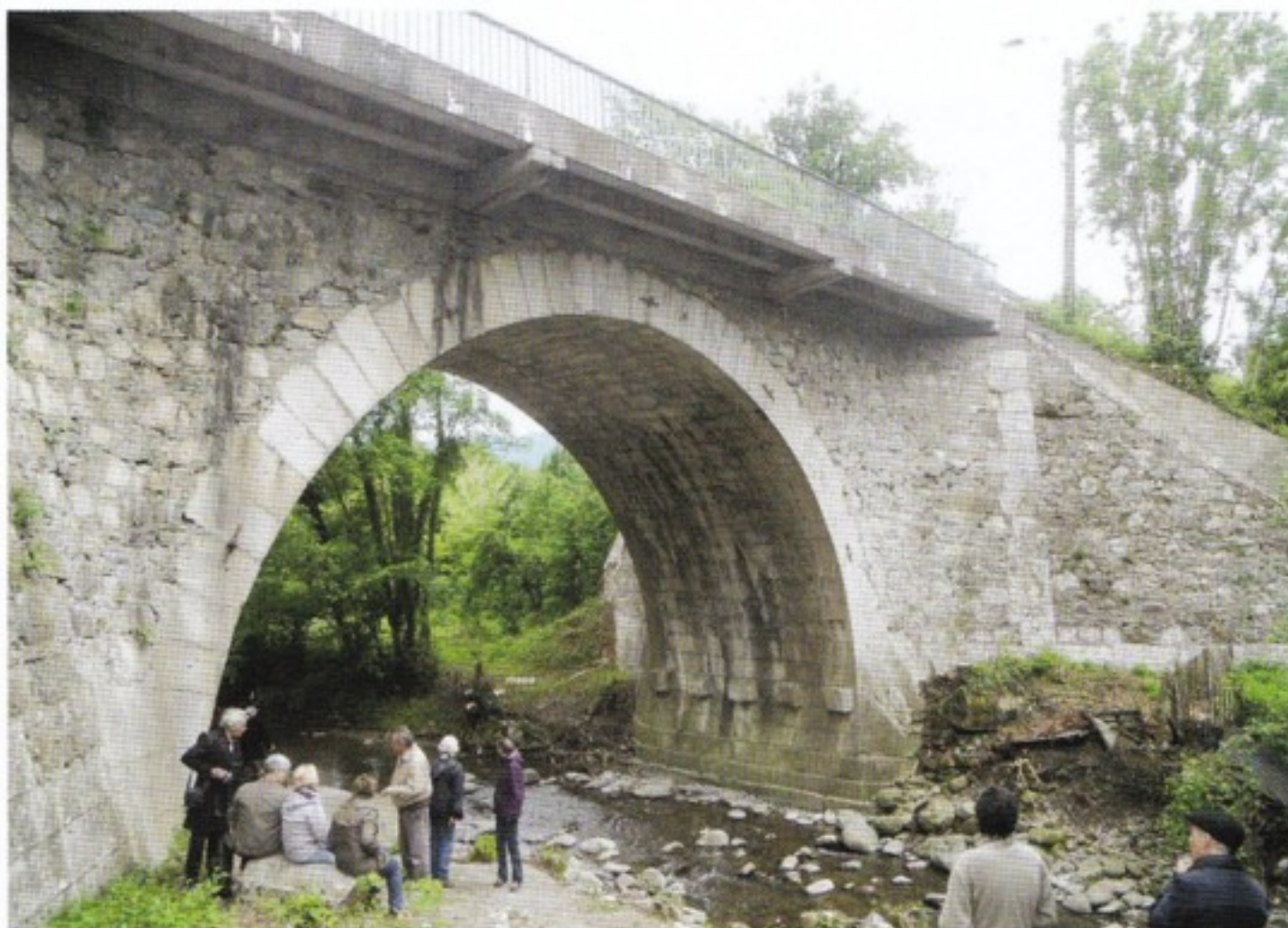
Le pont avant sa destruction.
