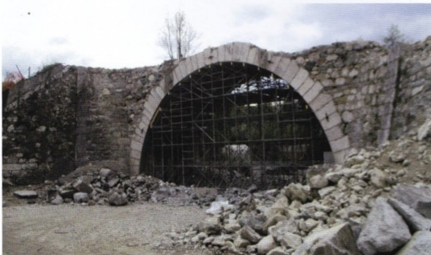
Le pont en cours de démolition.
