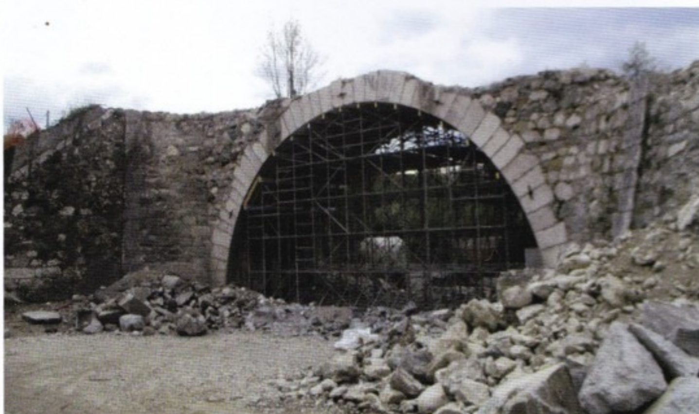
Le pont en cours de démolition.
