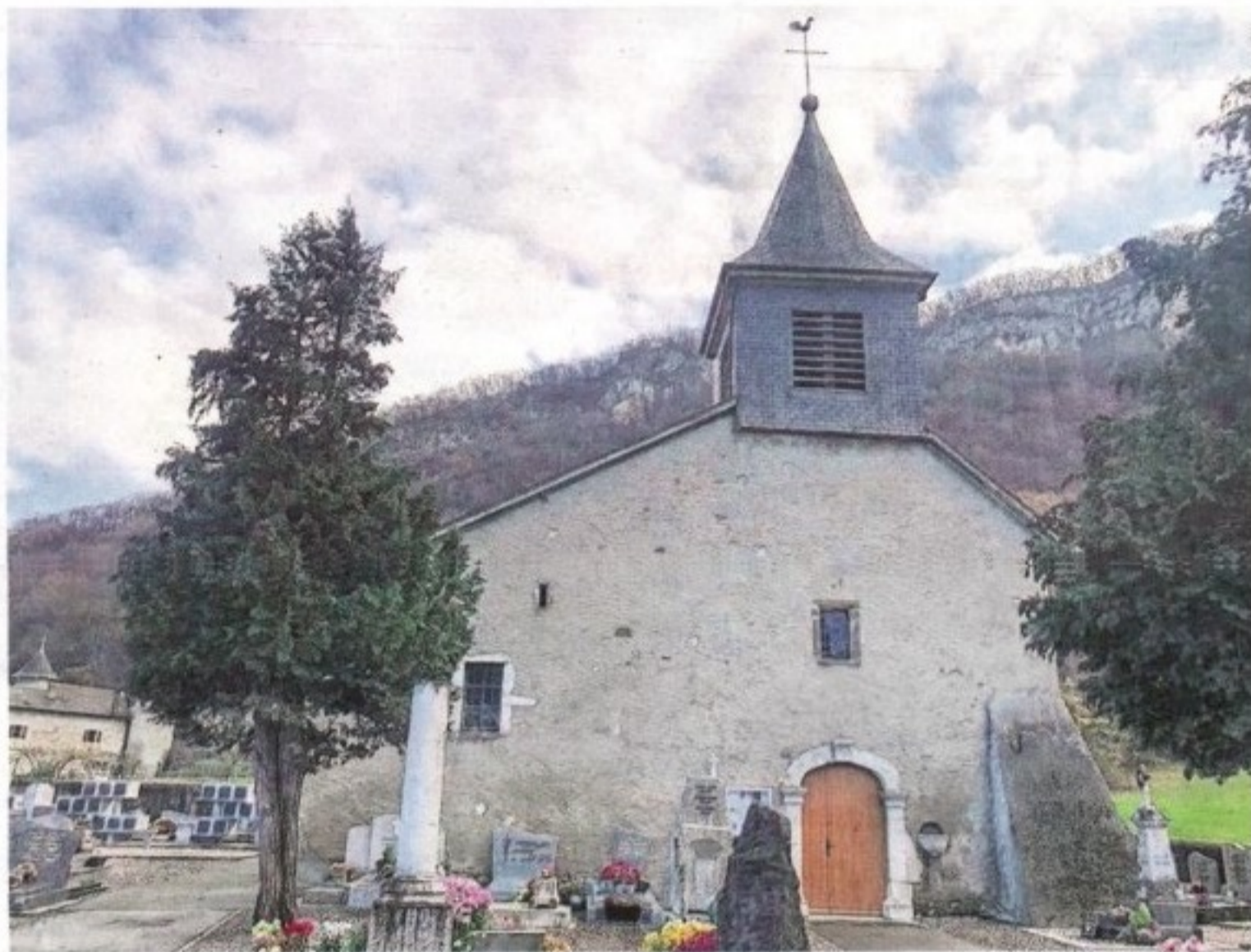
Sans cloche et avec un bénitier à l'extérieur, la chapelle d'Étrembières est toujours debout, adossée au Salève.
