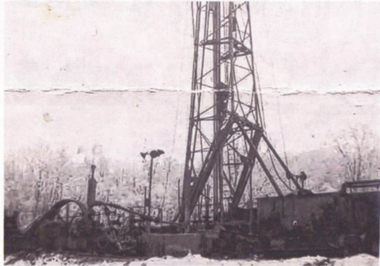
Un cliché rare du derrick installé à Bellossy pour forer le sous-sol à la recherche de traces de pétrole.
