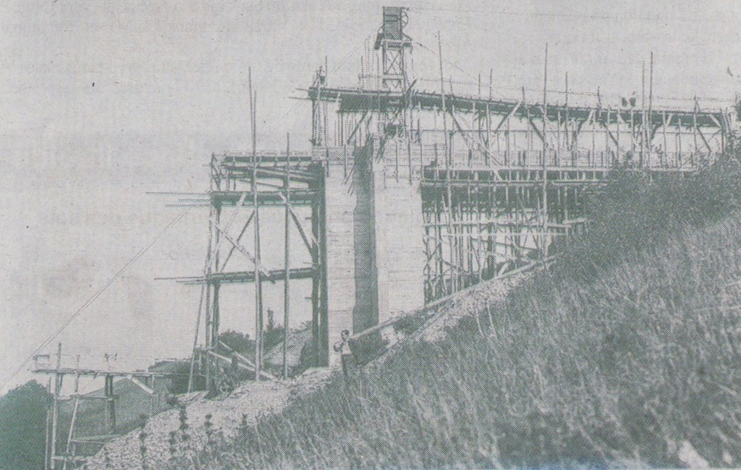
Construction du téléphérique du Salève en 1931. © STS et Fondation Braillard
